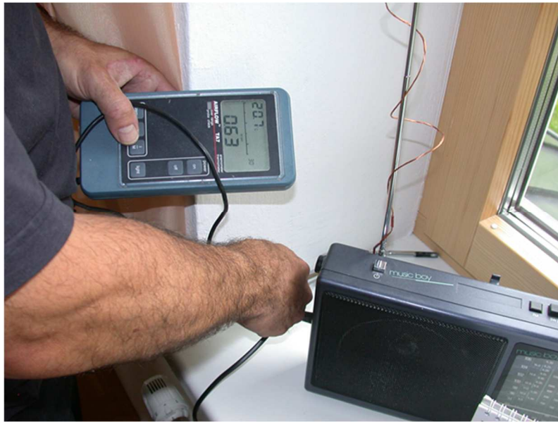
Leckageortung mittels Thermoanemometer in einem Steirischen Wohnhaus (Foto: AEE INTEC)
